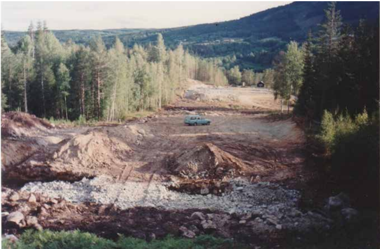
Anleggsarbeidet i full gang. Banen var korta inn til 200 meter og gravd ned i terrenget.
