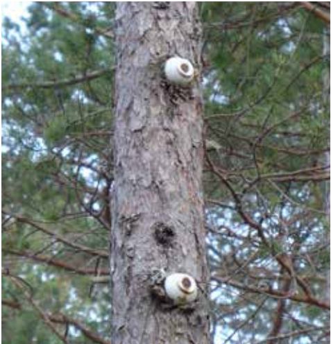
Det vart strekt telefonliner gjennom skogen frå standplass til grav. Stolpane sto jo der! Bilde frå gamlebanen i Rollag.
